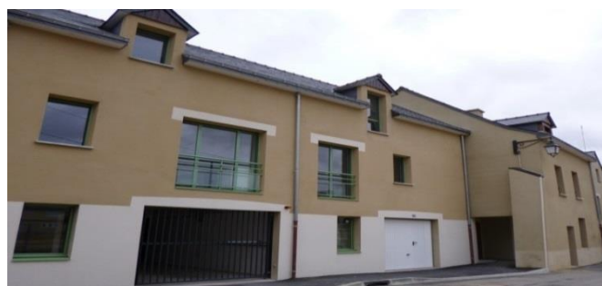
Résidence-FJT « Le liberté » : 60 rue Notre-Dame, Redon 3 logements T4, soit 9 chambres T1 en appartements dont seulement 6 T1 sont conventionnés FJT
